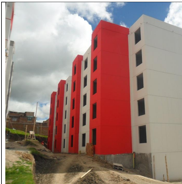
PROCESO CONSTRUCTIVO AMARRADO DE HIERRO
