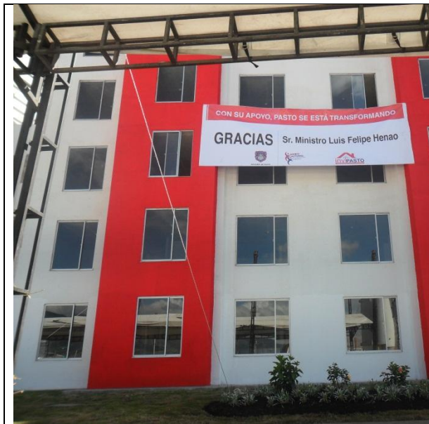
OBRAS DE URBANISMO
