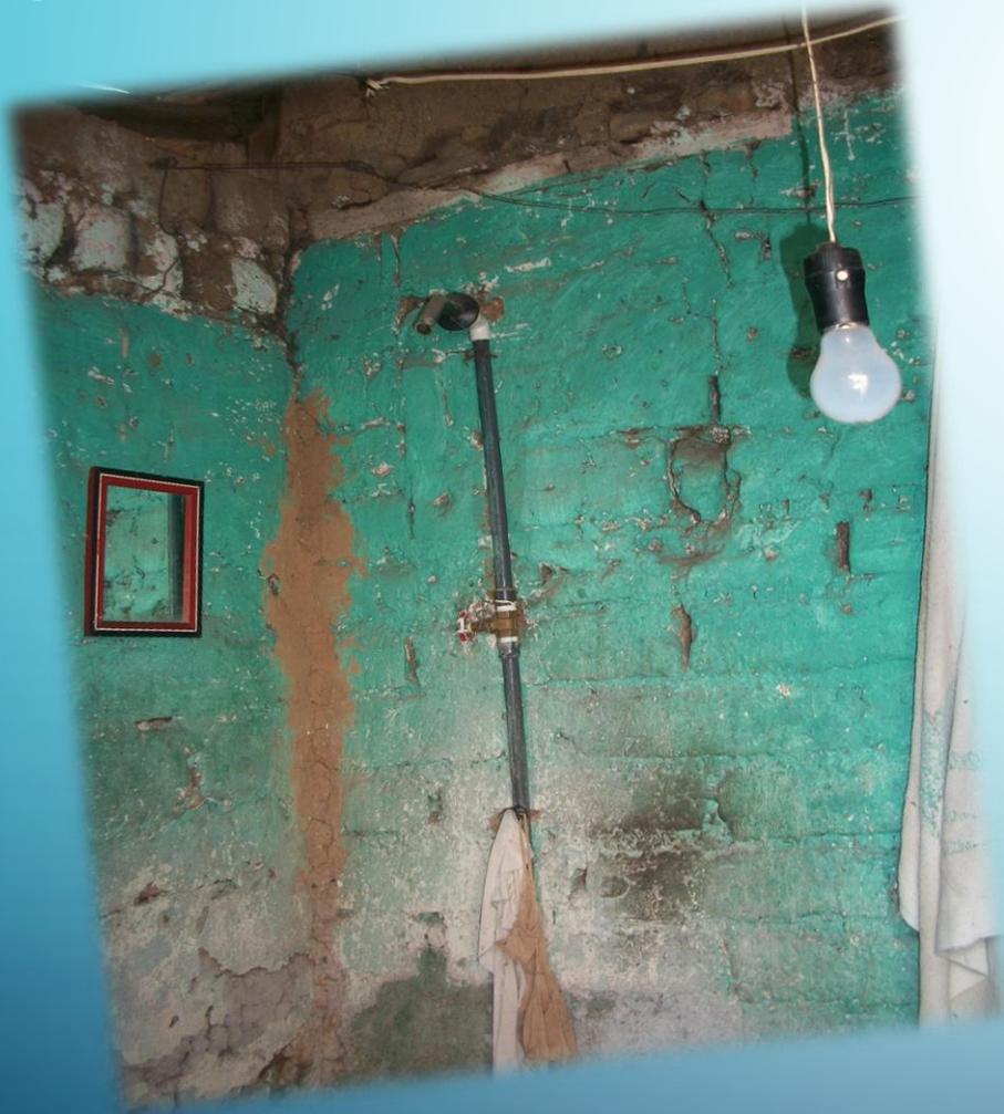
DUCHA: Tubería expuesta, accesorios deteriorado
