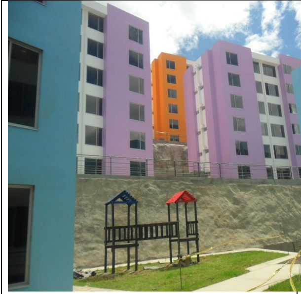
OBRAS DE URBANISMO
