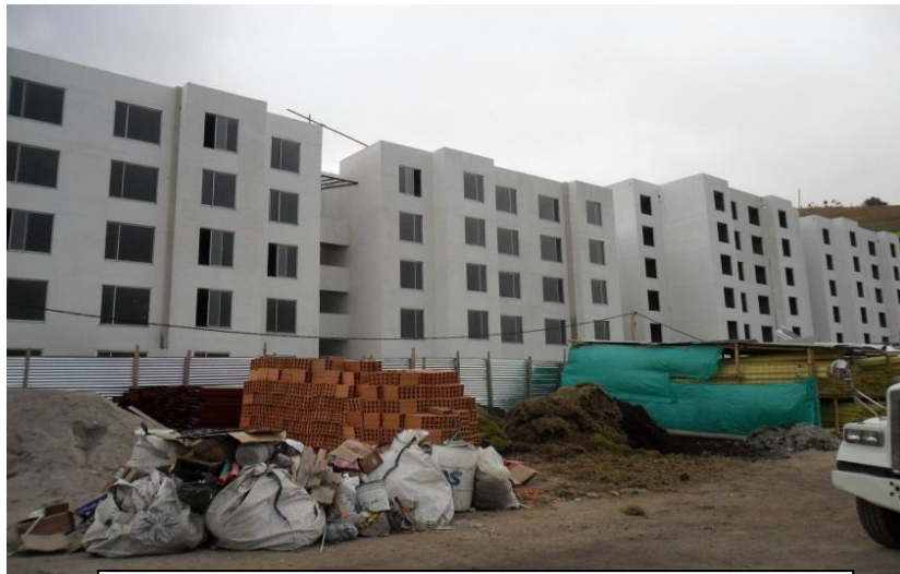
Proceso Constructivo colocación de ventanas
