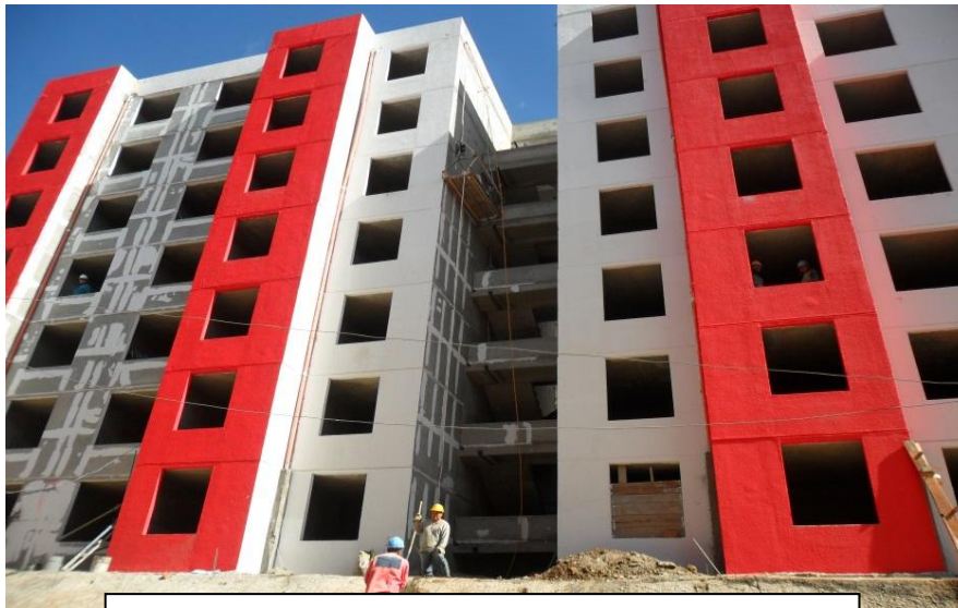
Proceso Productivo Pintura de placa Torre 6
