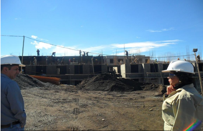
Proceso constructivo formaleteo de Muros
