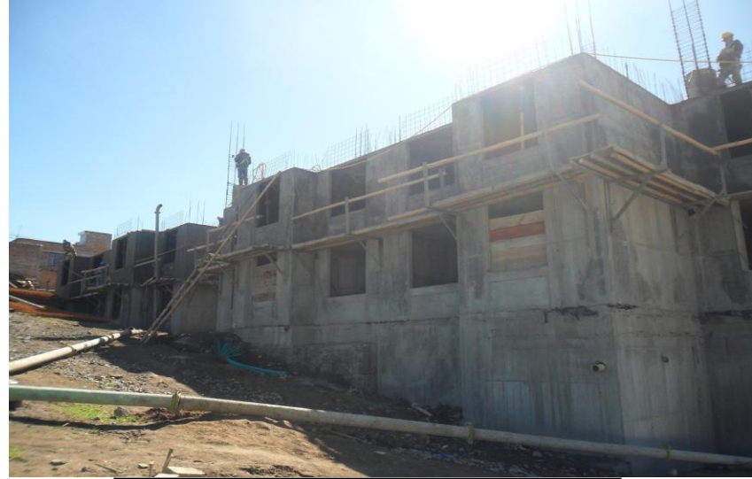
Desencoframiento de Muros
