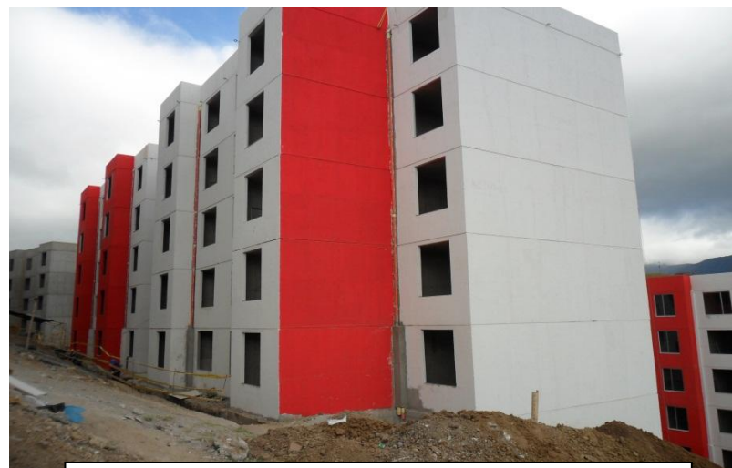
Proceso Constructivo Pintura
