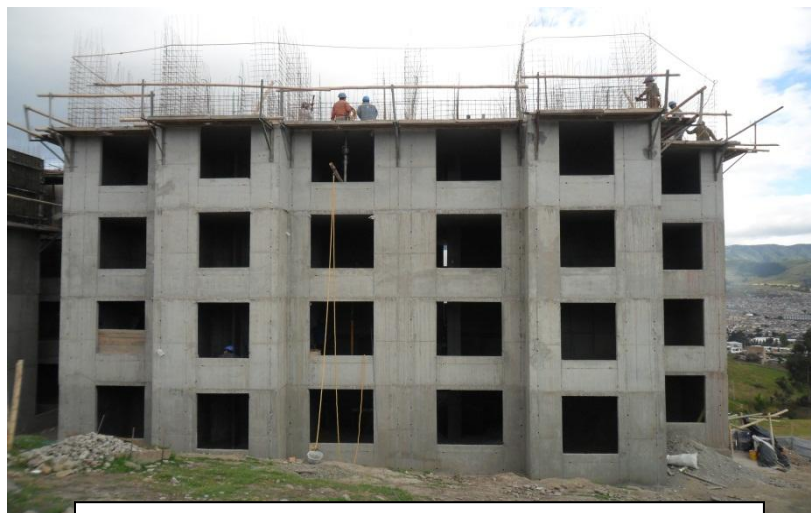
Proceso Constructivo Acero de Refuerzo Torre 3
